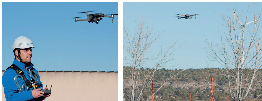
Imágenes 7 y 8. Piloto de dron supervisando la instalación de placas solares. Fuente: Konery
