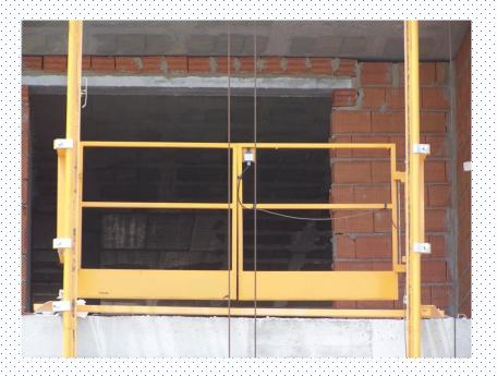
Las puertas de acceso o barandillas móviles instaladas en cada parada estarán dotadas de enclavamiento eléctrico y bloqueo mecánico, de tal manera que el movimiento de la citada plataforma implique que la puerta está cerrada y que no se puede abrir hasta que la plataforma no se encuentre en su posición correcta.
