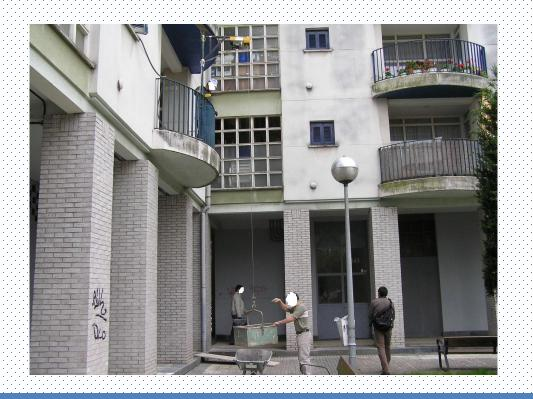
El operador del maquinillo está protegido por la barandilla existente en el balcón del edifico en el que se realizan trabajos de rehabilitación o reforma. Debe comprobarse previamente que estos elementos de cerrajería existentes son estables y resistentes.
