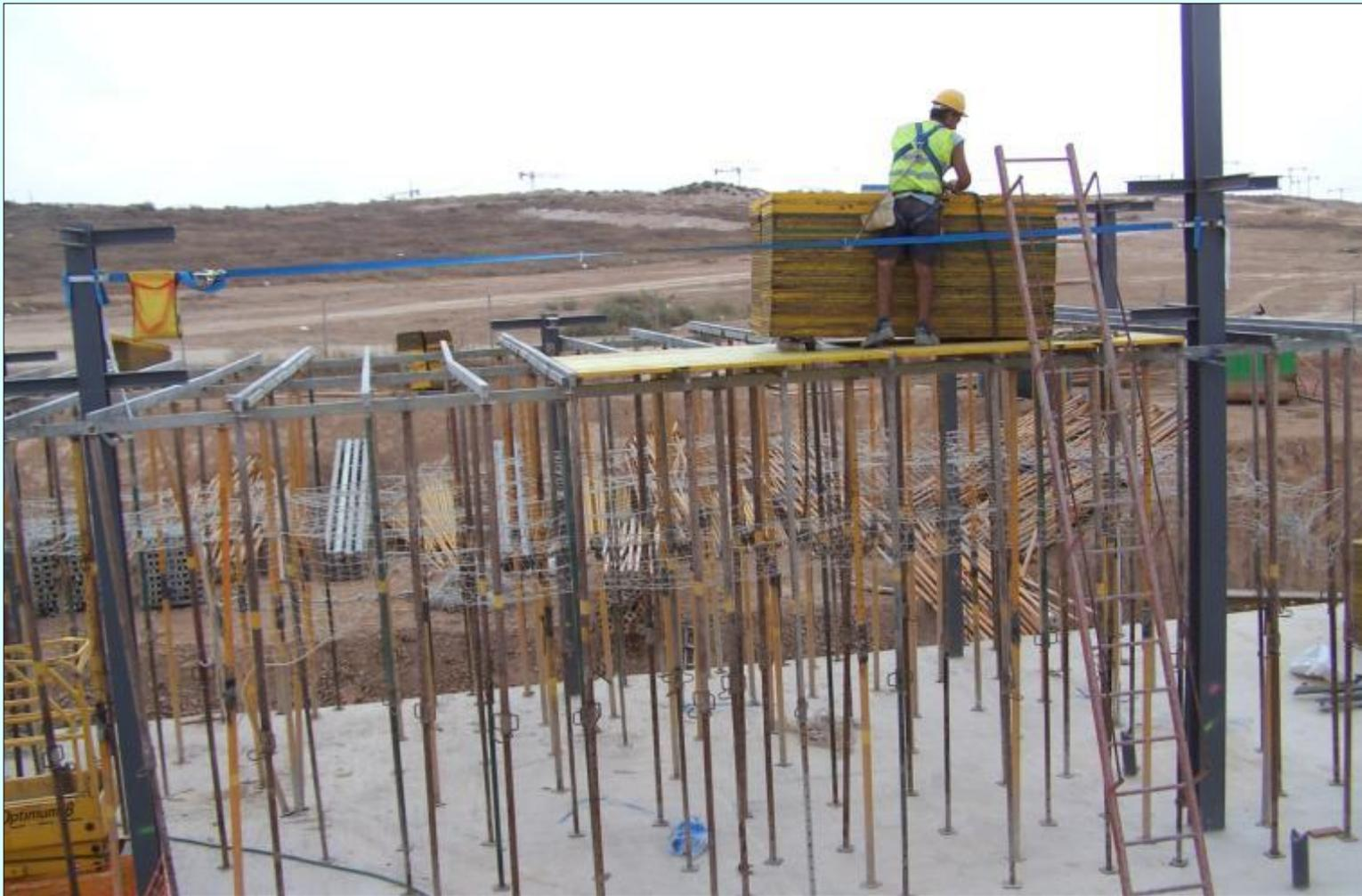
**Fijación en vigas H para fabricación de encofrados**
