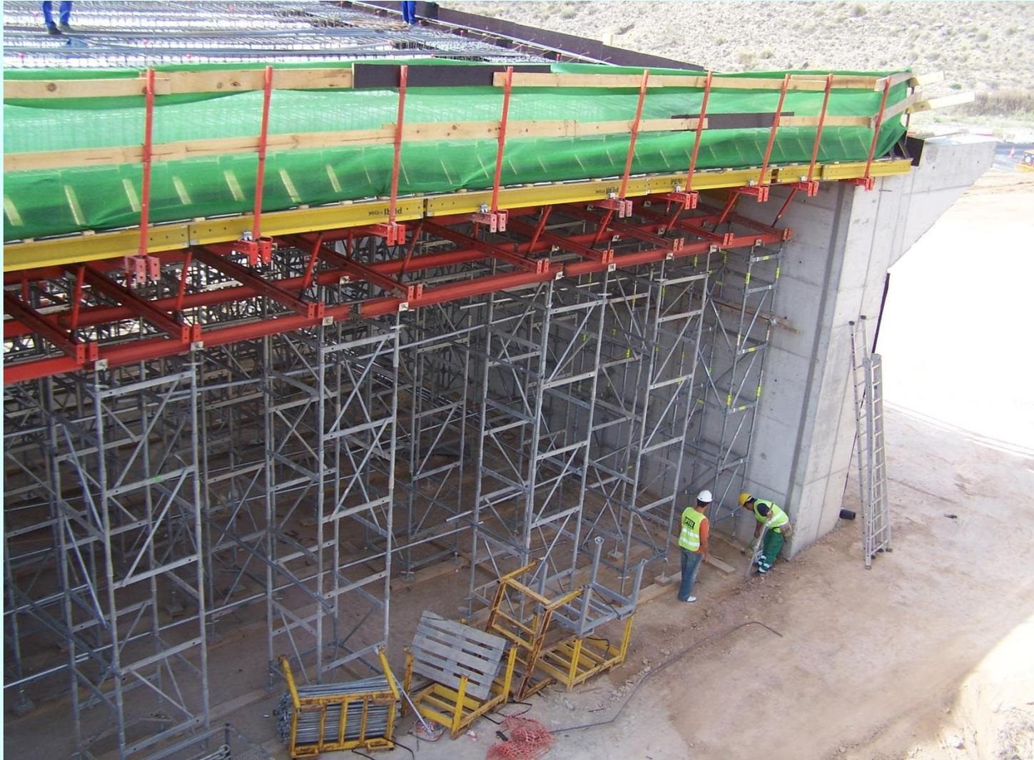
**Ejemplos. Poste incorporado en el sistema de encofrado**
