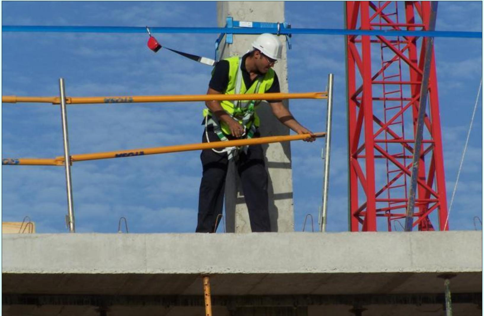
**Montaje y desmontaje de SPPB / barandilla intermedia**
