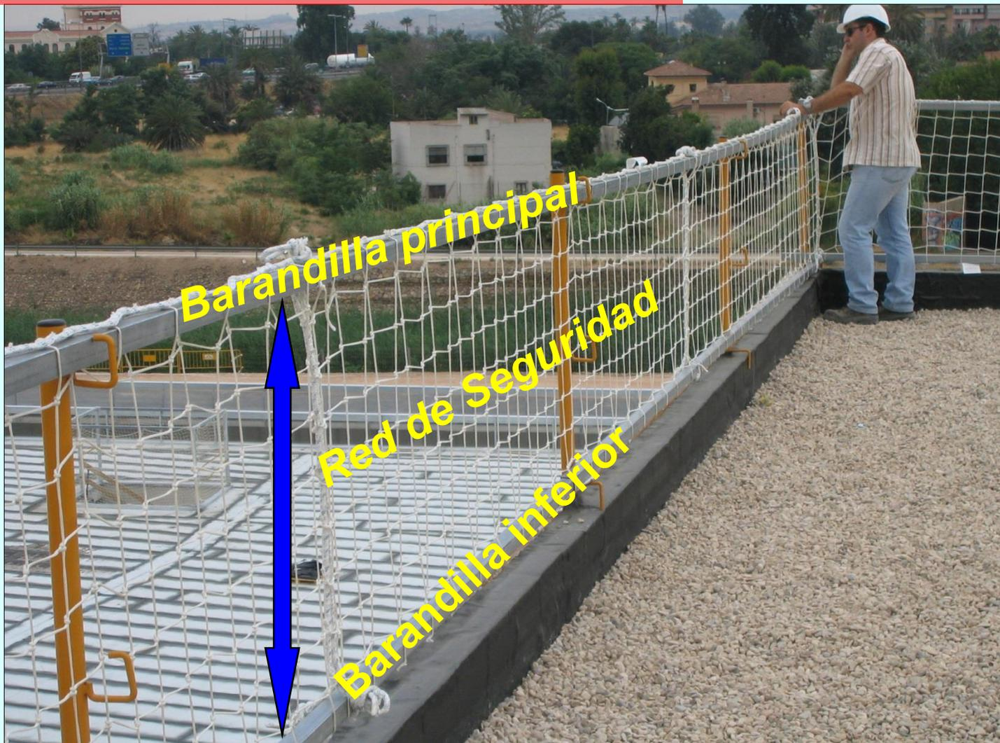
**Red de Seguridad sujeta a una estructura soporte para su utilización vertical**
