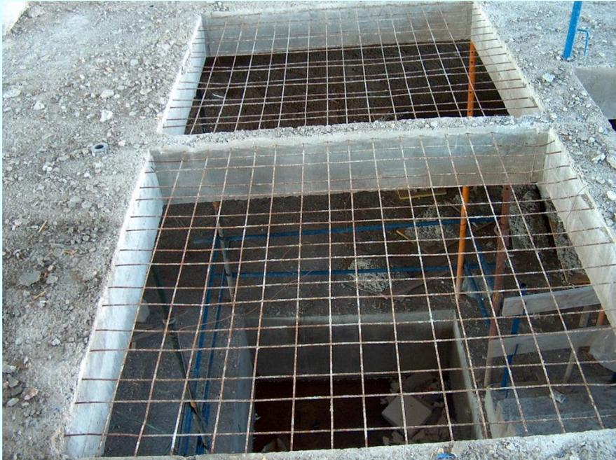
Se utiliza principalmente para proteger huecos de medianas dimensiones que resultan de complicada cubrición con tableros (huecos ascensores). Se colocarán mallazos de  $\varnothing$  10 cm. o, en caso de ser mayor, dos mallazos solapados para que no se pueda introducir el pié en las cuadrículas.
