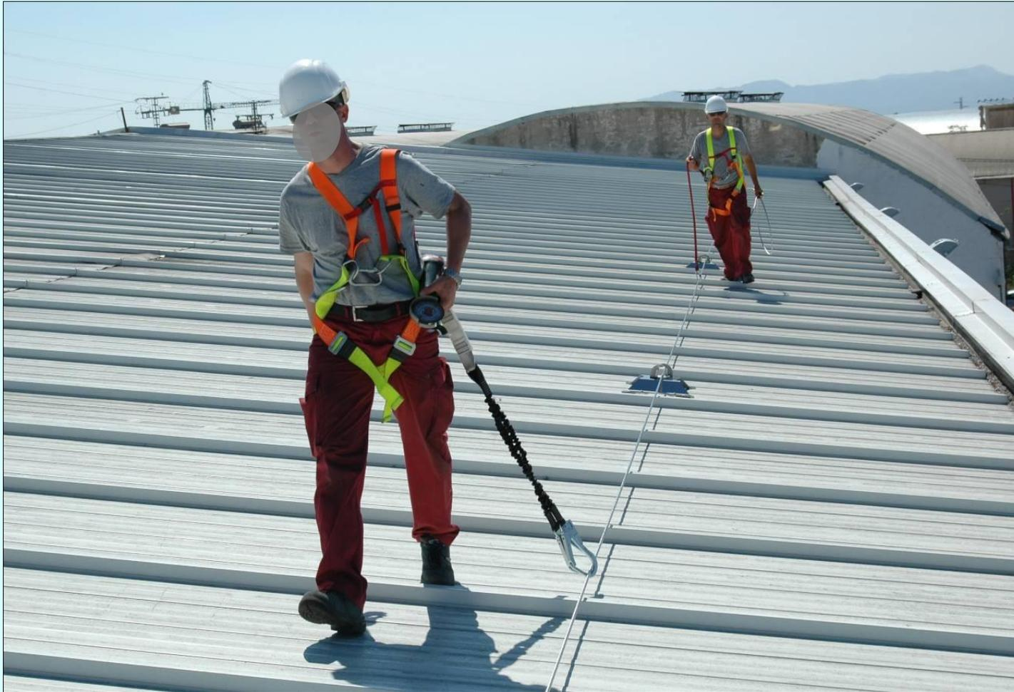
Dispositivos equipados con líneas de anclaje **flexibles** horizontales ( $\leq 15^\circ$ )
