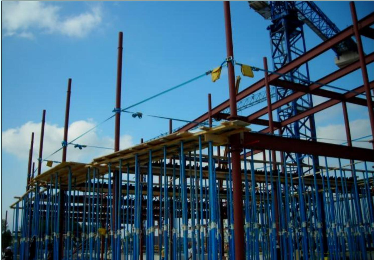
**Fijación en pilares redondos para fabricación de encofrados**
