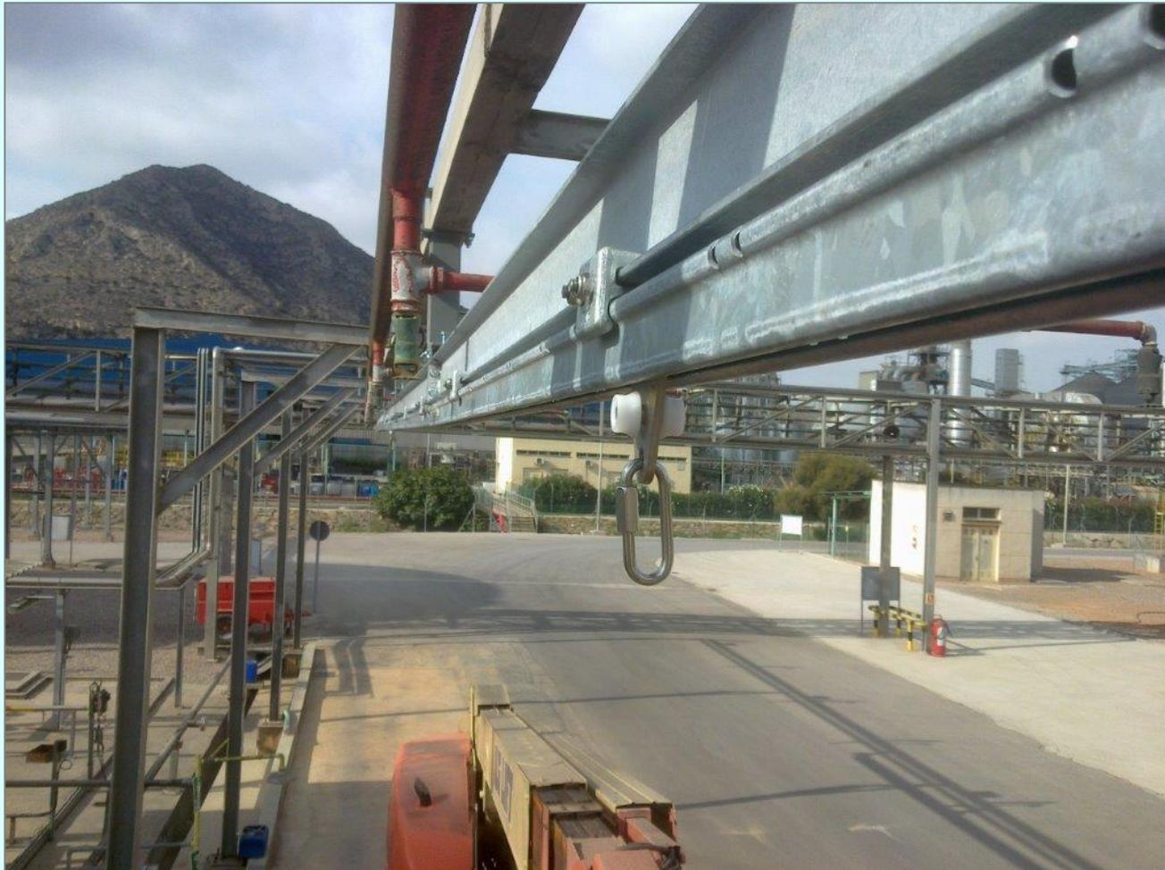
Dispositivos equipados con líneas de anclaje rígidas horizontales ( $\leq 15^\circ$ )
