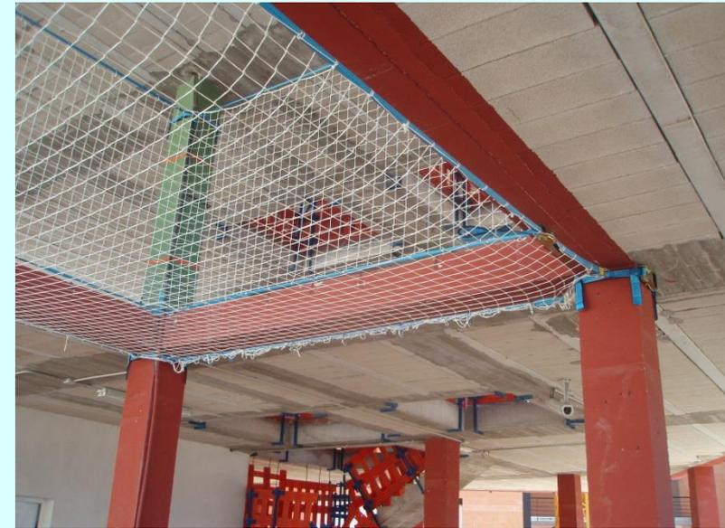
**Sistema S en estructuras de hormigón armado – con Sistema Multigarben.**
