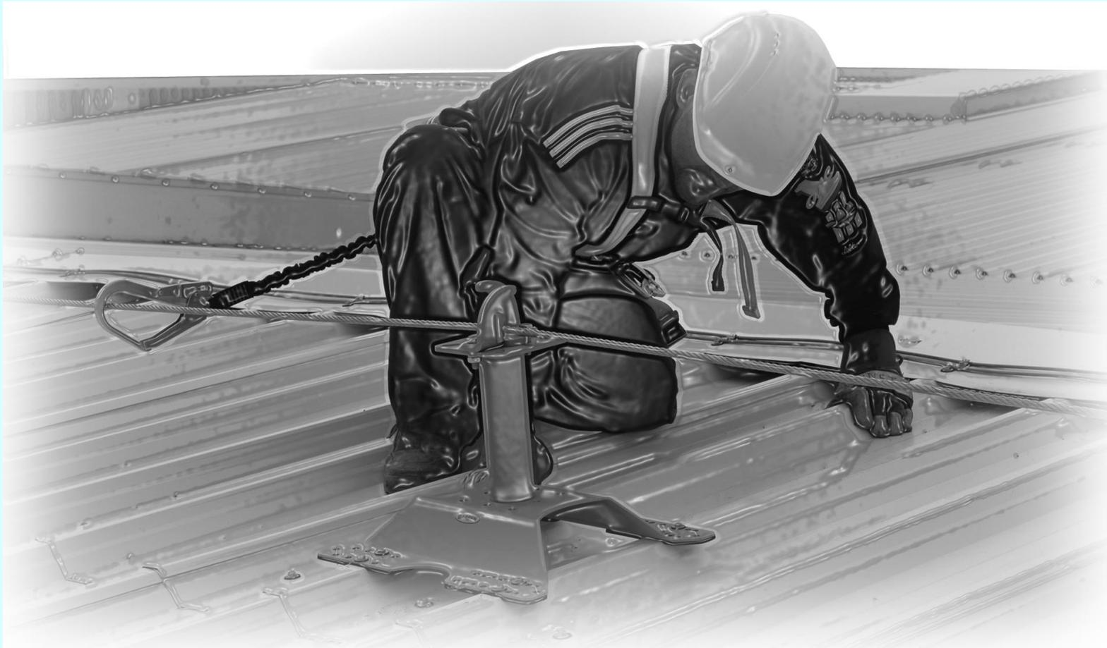
Dispositivos equipados con líneas de anclaje flexibles horizontales ( $\leq 15^\circ$ )
