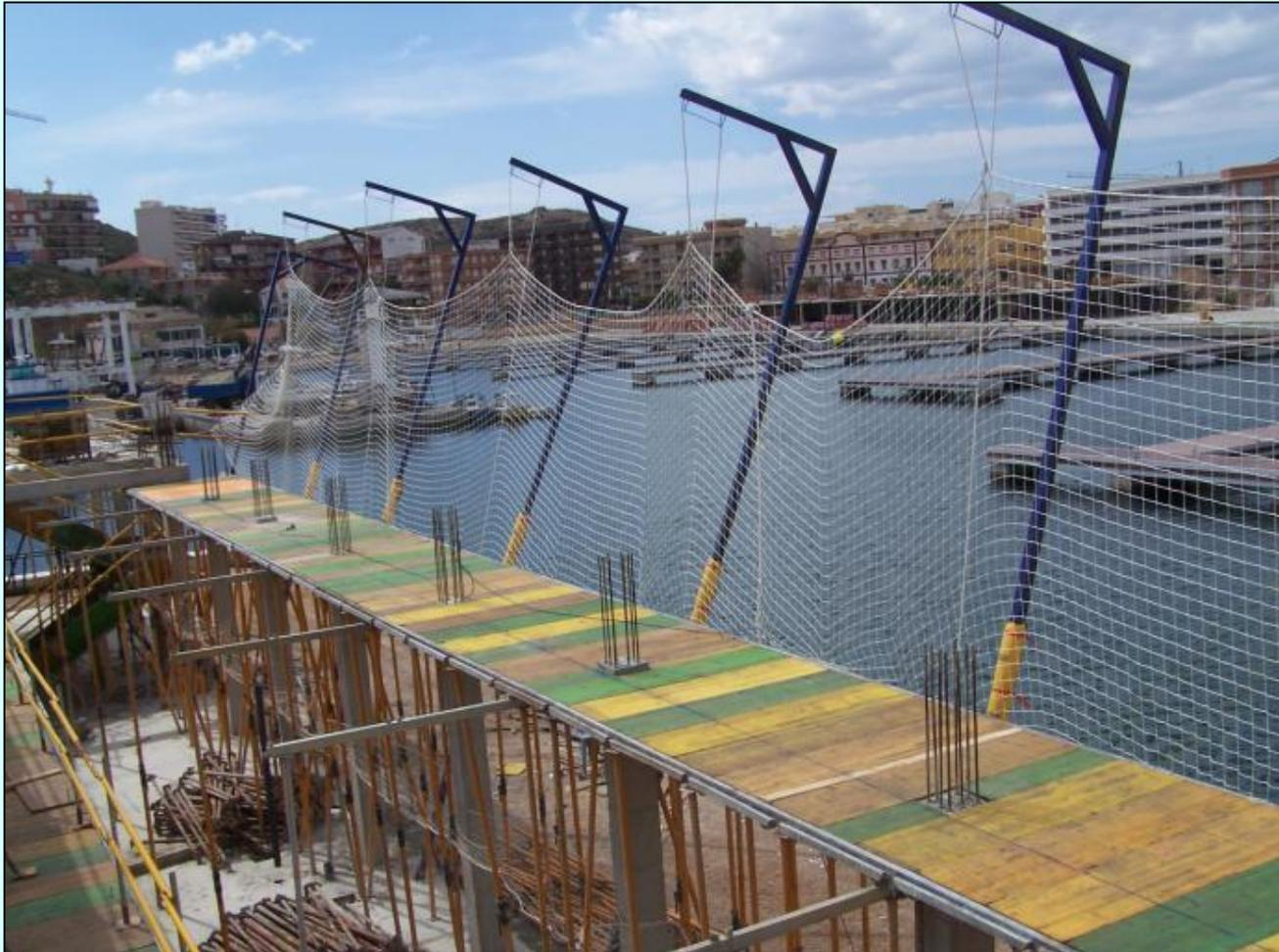
**Redes de seguridad bajo forjado / antes de colocar el mecano**
