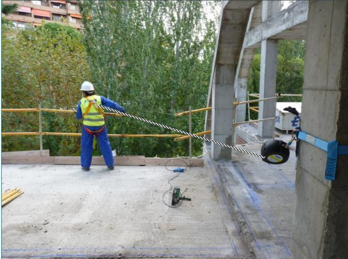
**Montaje y desmontaje de SPPB / trabajador sujeto a bloque retráctil**
