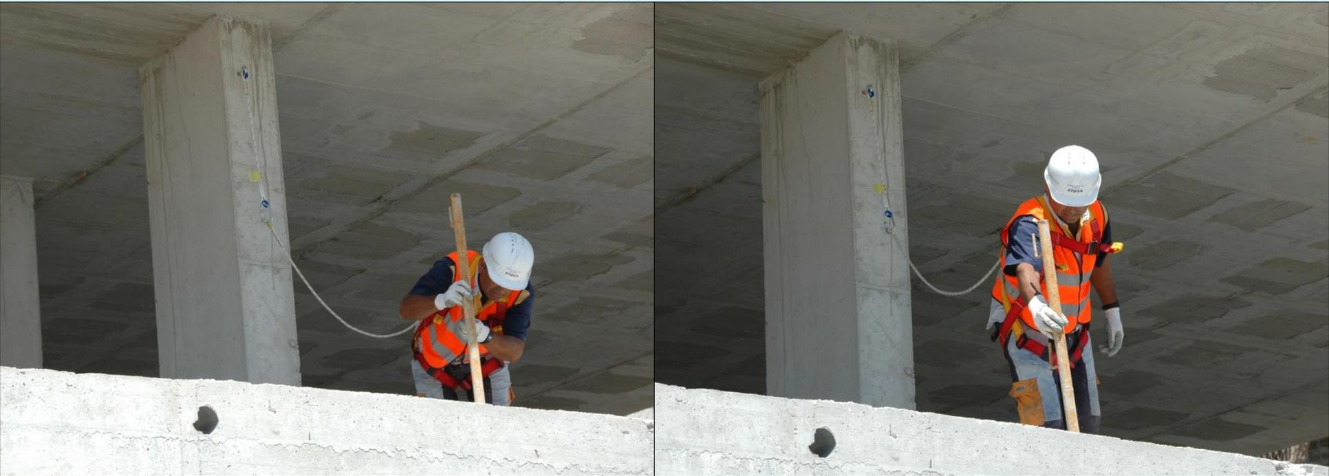
**Son dispositivos de anclaje diseñados con cuerda de poliamida de alta tenacidad industrial  $\varnothing 11\text{mm}$ , que fijados mediante anclajes metálicos a estructuras de hormigón armado, pilares, paramentos verticales de hormigón fisurado/no fisurado, armado u otros elementos particularmente en obras de construcción e industrial son utilizados para la sujeción de arneses de seguridad EN361 con sistemas de amarre EN354, EN355 y EN358.**
