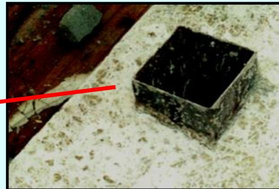
**Cajetín metálico embutido en la armadura del zuncho**
