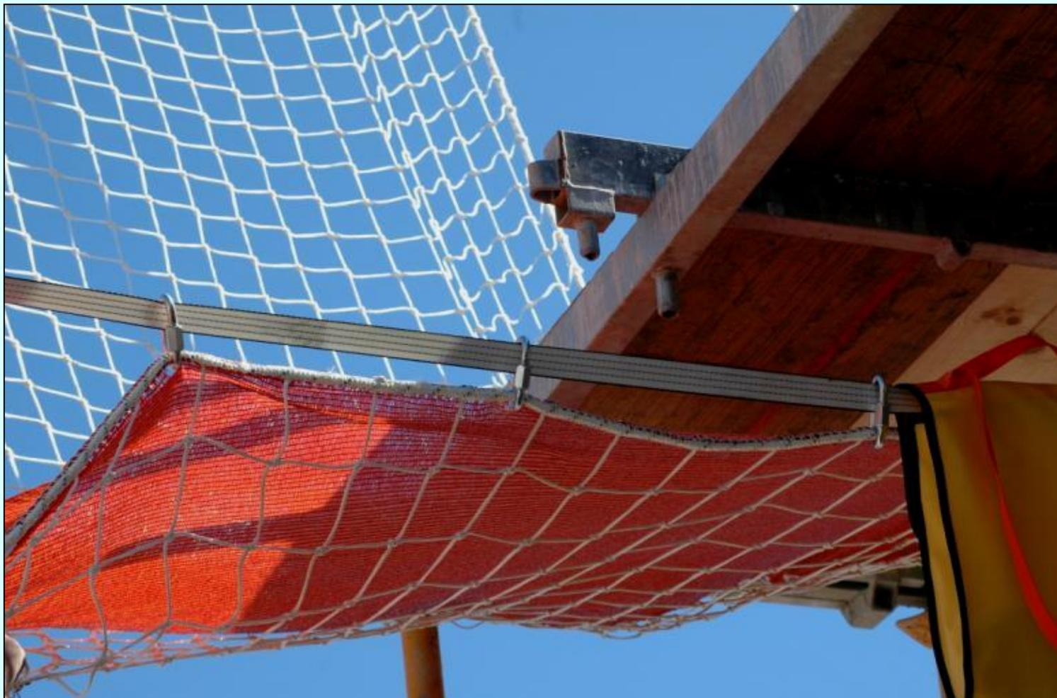
**Red sujeta a línea de anclaje mediante eslabones rápidos (maillón)**
