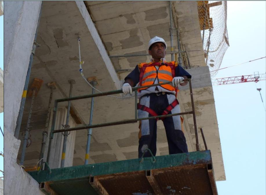
**Son dispositivos de anclaje diseñados con cuerda de poliamida de alta tenacidad industrial  $\text{\O}11\text{mm}$ , que fijados mediante anclajes metálicos a estructuras de hormigón armado, pilares, paramentos horizontales de hormigón fisurado/no fisurado, armado u otros elementos particularmente en obras de construcción e industrial son utilizados para la sujeción de arneses de seguridad EN361 con sistemas de amarre EN354, EN355 y EN358.**
