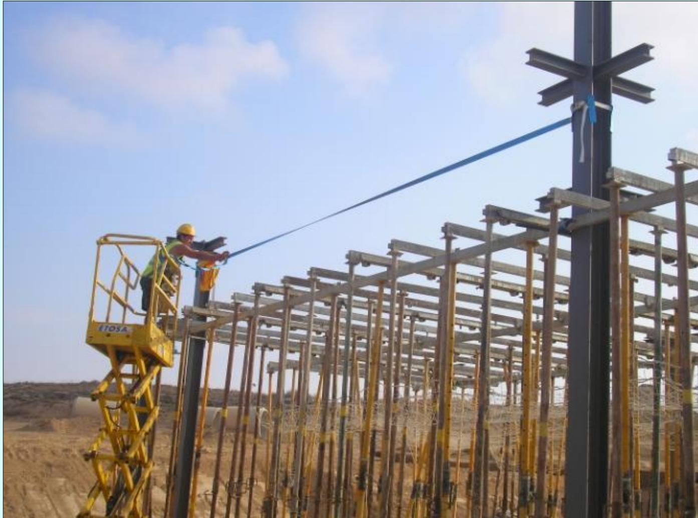
**Fijación en vigas H para fabricación de encofrados**
