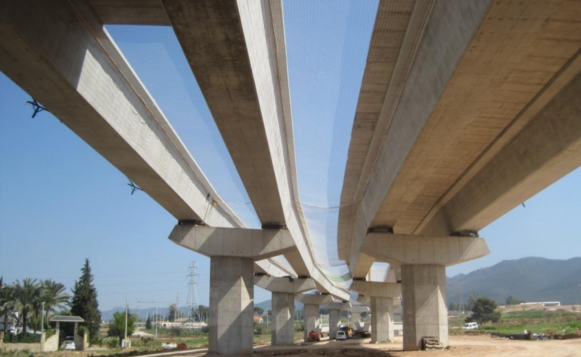
Redes de seguridad horizontales para proteger la caída interior durante la ejecución de las prelosas
