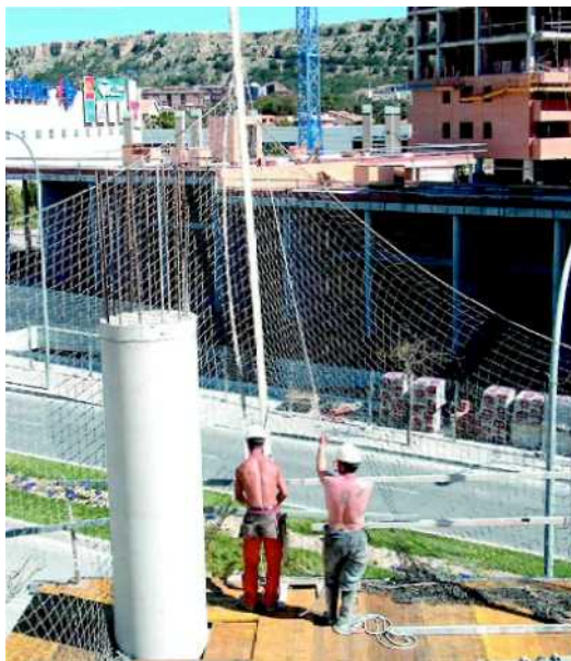
315. irudia. Sareak baranden atzetik josten ahaleginduko gara.
