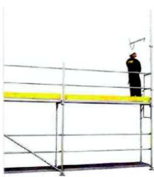
2. Markoa muntatzea L azpimarkoa lazpimarkoan bermatuko da. 237. irudia
