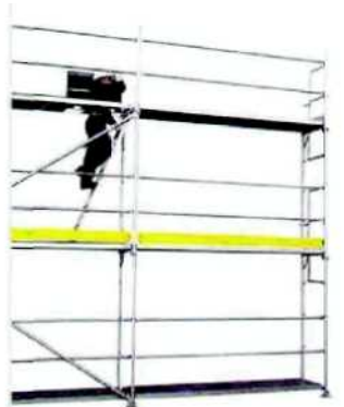
11. Muntaketaren jarraipena. Langilea goiko solairura igo daiteke segurtasun osoz.
