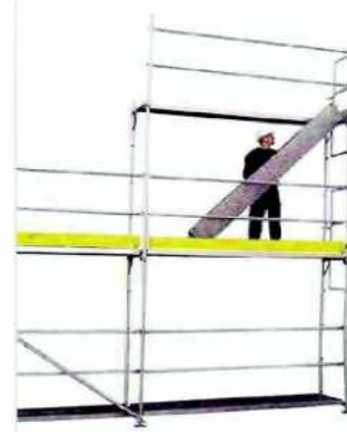
9. Plataformak jartzea Marko itxietan bermatuta munta daitezke plataformak.
