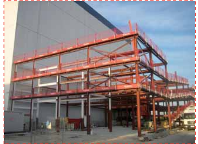
Obra "C.C. Xátiva". Detalle instalación protecciones patios obra.
