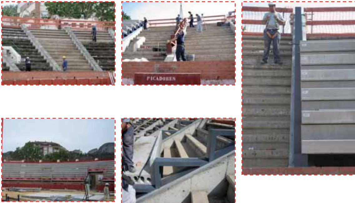
Detalle proceso de ejecución del graderío inferior. Equipos de protección empleados y medidas preventivas aplicadas.
