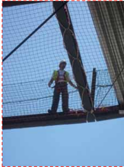
Detalle proceso montaje cubierta Deck. Protecciones colectivas empleadas.
