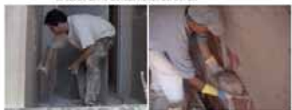
Figura 84 - Yeso: trabajo en paredes.
