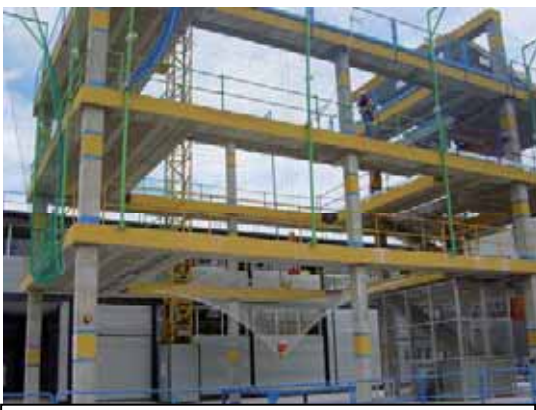
Centro I+D+i de Medios de Protección Colectiva de AIDICO (Instituto Tecnológico de la Construcción)
