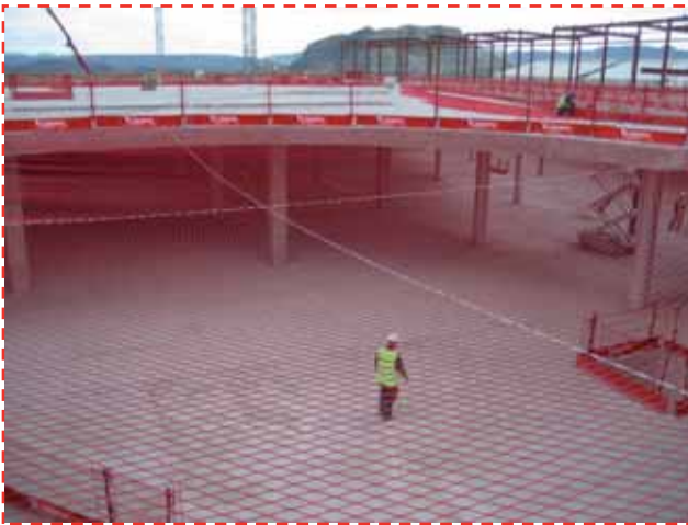
Obra "C.C. Xátiva". Detalle instalación protecciones patios obra.
