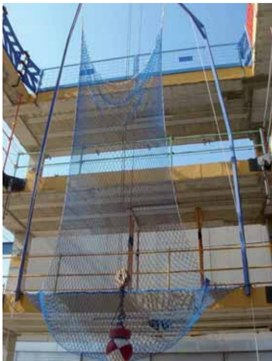
Ensayo dinámico de resistencia sobre Red de Seguridad del sistema V (ensayo satisfactorio tras 1er impacto)
