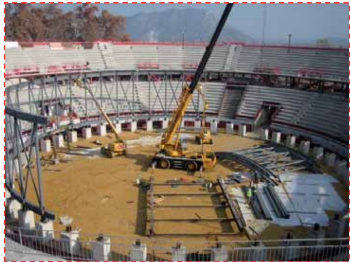
Detalle proceso de ejecución del anillo central. Organización zona de trabajo y medios auxiliares empleados.
