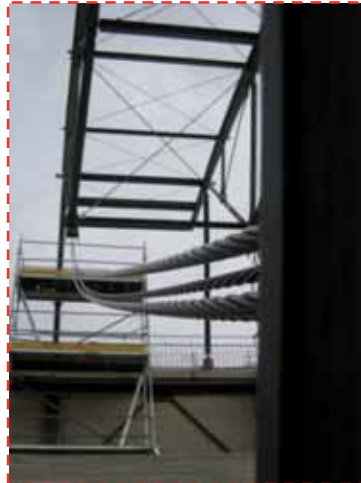
Detalle proceso de preparación e instalación sistema elevación. Medios auxiliares empleados.
