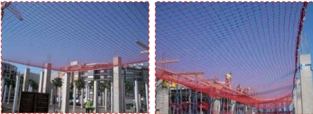
Obra "I.E.S. Burriana". Detalle instalación redes tipo S para protección riesgo caída por patio central en operaciones de encofrado, ferralla y hormigonado del primer forjado, previo al montaje del sistema.
