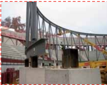
Detalle proceso de ejecución del anillo central. Organización zona de trabajo y medios auxiliares empleados.
