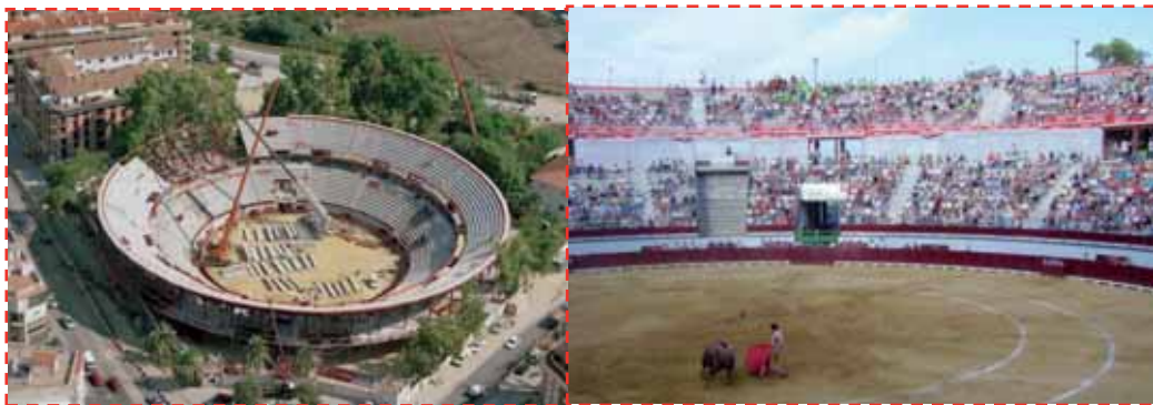
Imagen aérea fase final montaje graderío superior y detalle sistema provisional de borde durante festejo taurino.
