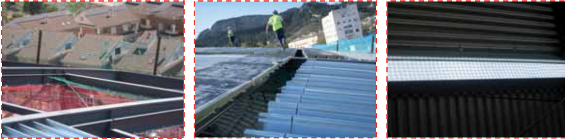
Detalle proceso de montaje nueva red de protección para protección hueco canalones.
