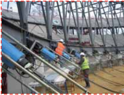
Detalle proceso de preparación e instalación sistema elevación. Medios auxiliares empleados.
