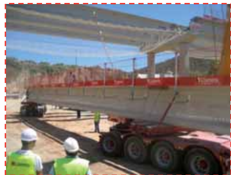
Obra "Variante Higuieruelas". Detalle instalación protecciones colectivas integradas en proceso de ejecución del puente rambla Peñaroya.
