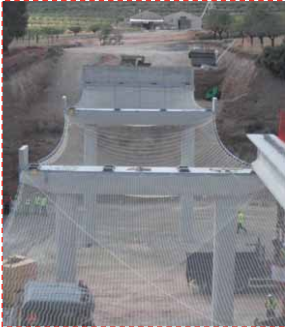
Obra "Variante Higuieruelas". Detalle instalación protecciones colectivas integradas en proceso de ejecución del puente rambla Peñaroya.
