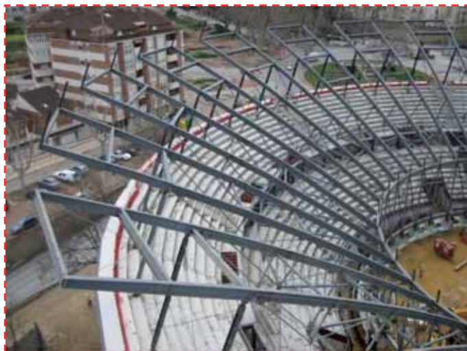
Detalle estructura cubierta. Soportes anillo central y perímetro exterior; argollas para anclajes de redes.
