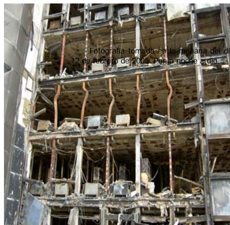
Deformación de pilares en planta 9, por falta de protección contra incendios debido a la obra que se realizaba.
