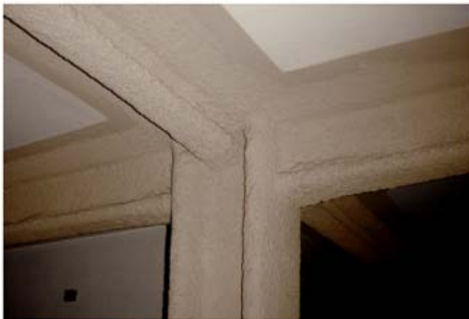
Proyectado de fibras (flocage) como revestimiento ignífugo en estructura metálica
