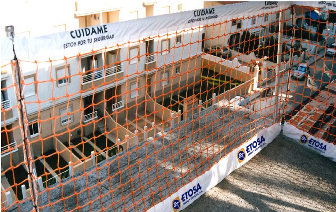
Red de Seguridad sujeta a una estructura soporte mediante fundas de PVC tramada en poliéster.
