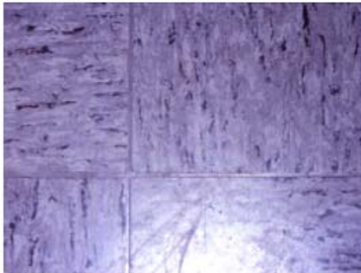
Pavimento de losetas vinílicas
