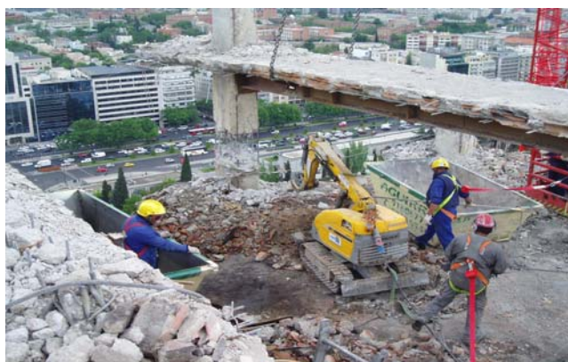
Trabajos con robot Brokk para demolición de forjados y pilares. Se observa al personal con utilización de arnés de seguridad anclado a línea de vida al encontrarse sobre el forjado.
