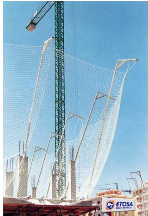
Red de Seguridad con cuerda perimetral >20 kN. sujeta a un soporte tipo horca.
