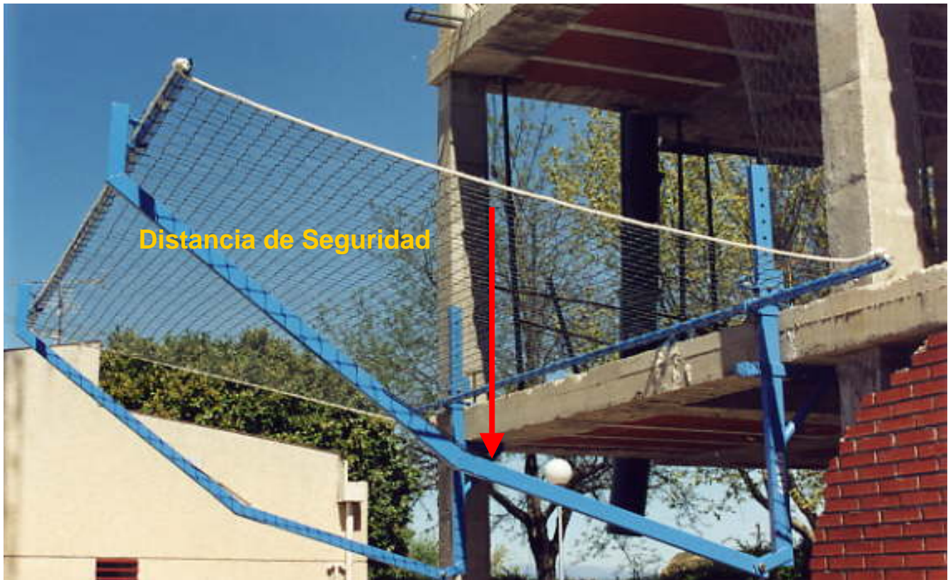
Red de seguridad sujeta a consolas para su utilización horizontal.
