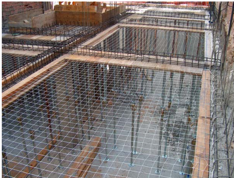
Ensayo dinámico UNE EN 1263-1
