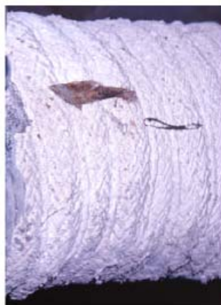
Calorifugación de tuberías
