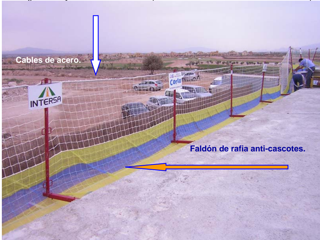
Red de Seguridad sujeta a una estructura soporte mediante fundas de PVC tramada en poliéster.
