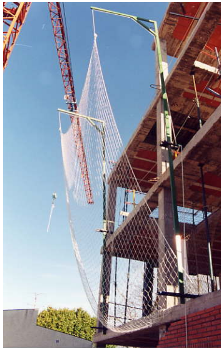
Red de Seguridad con cuerda perimetral >20 kN. sujeta a un soporte tipo horca.
