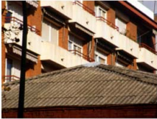
Placas de fibrocemento en cubierta
