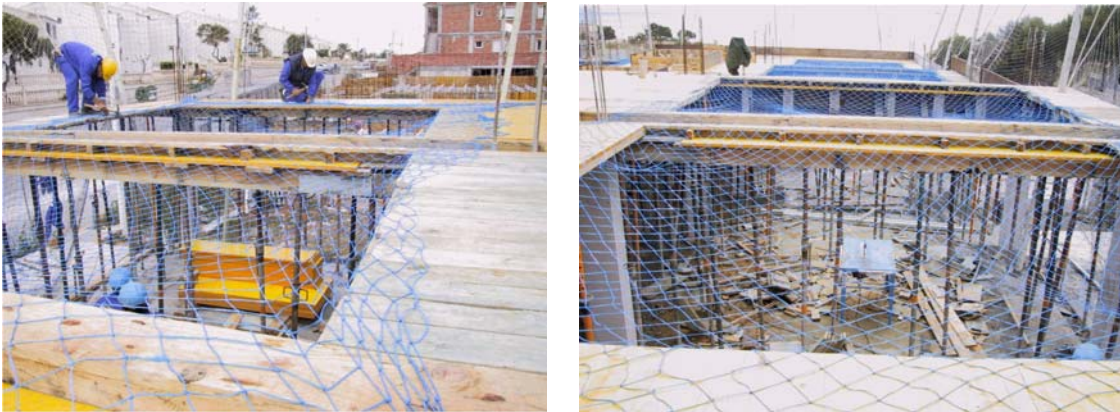
Figura 11 Proceso de colocación de las redes de seguridad de uso único en encofrados de madera para forjados unidireccionales con vigas de cuelgue.
