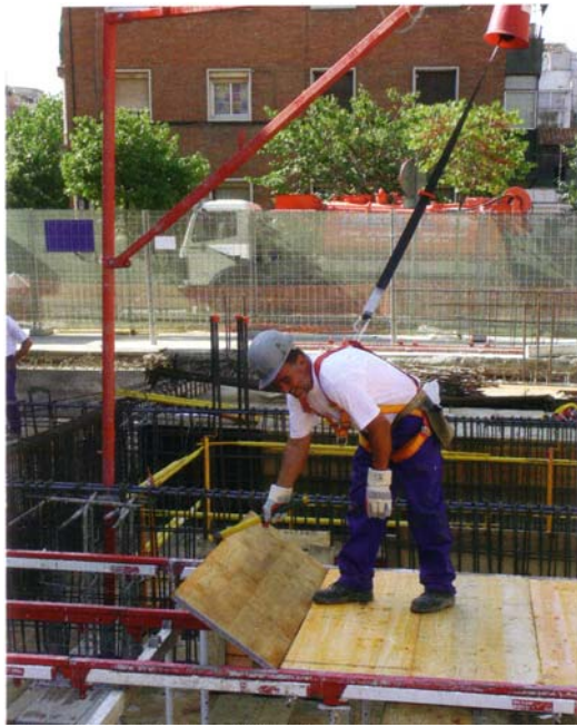
Figura 2 Dcha. Línea de vida y anclaje recuperable. Izq. Sistema alsipercha.
