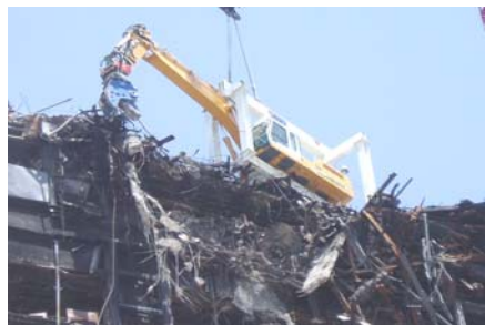
Demolidor aéreo manejado a distancia por personal en cesta.
