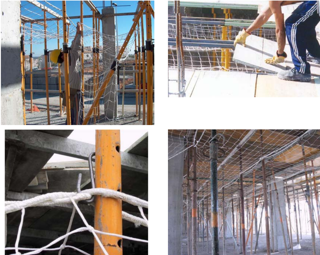
Figura 13 Proceso de montaje de las redes de seguridad bajo forjado reutilizables. (Sistema B)
