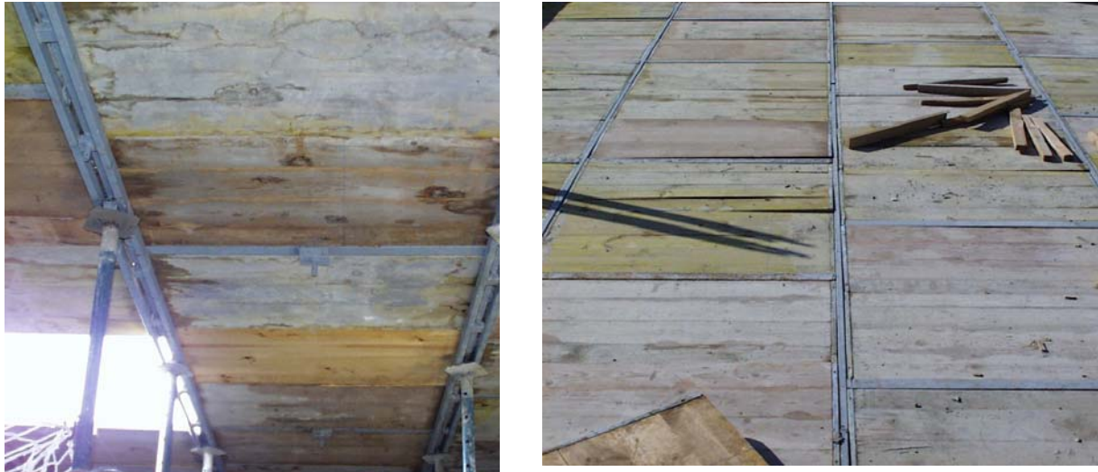
Figura 6 Sistema de encofrado no arriostrado visto inferiormente y por la cara superior.
