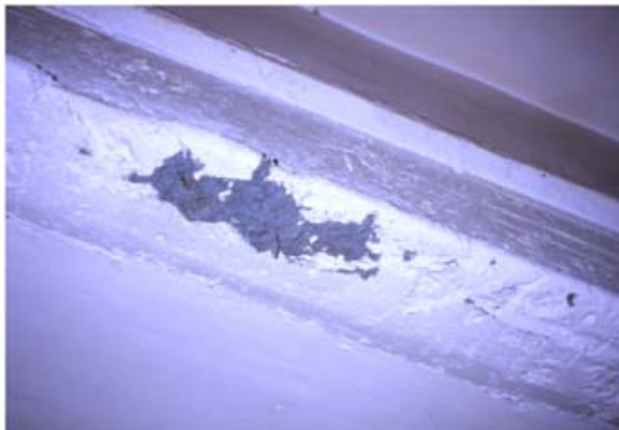
Proyectado de fibras sueltas como revestimiento ignífugo en iácena
