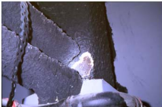
Proyectado de mortero y fibras como revestimiento ignífugo en pilar y iácena metálicas
