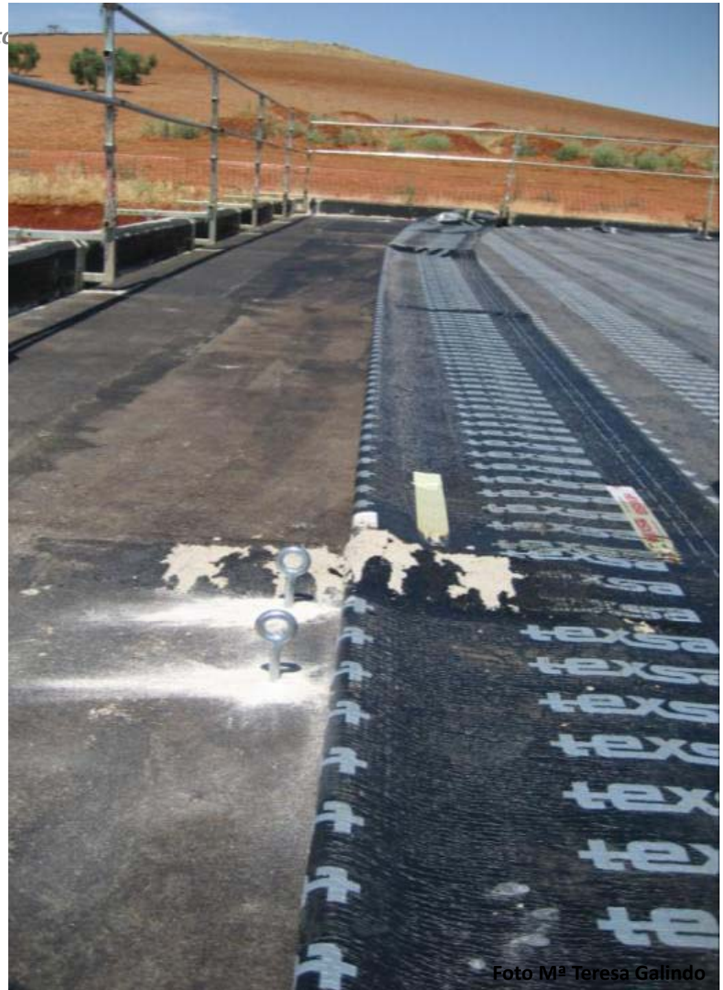
Instalación línea anclaje
