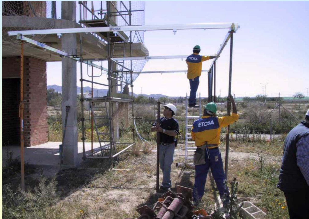
Montaje de vigas y sopandas
