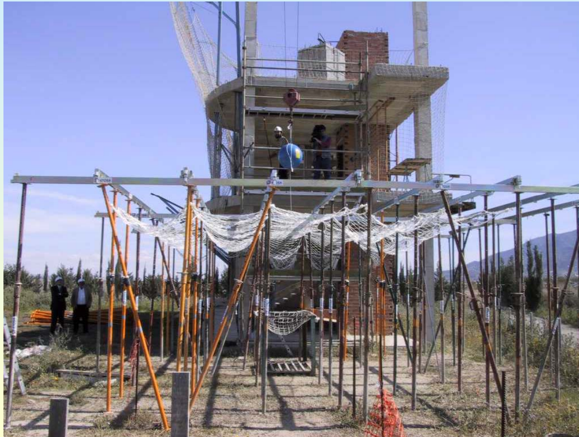
Colocación de redes
