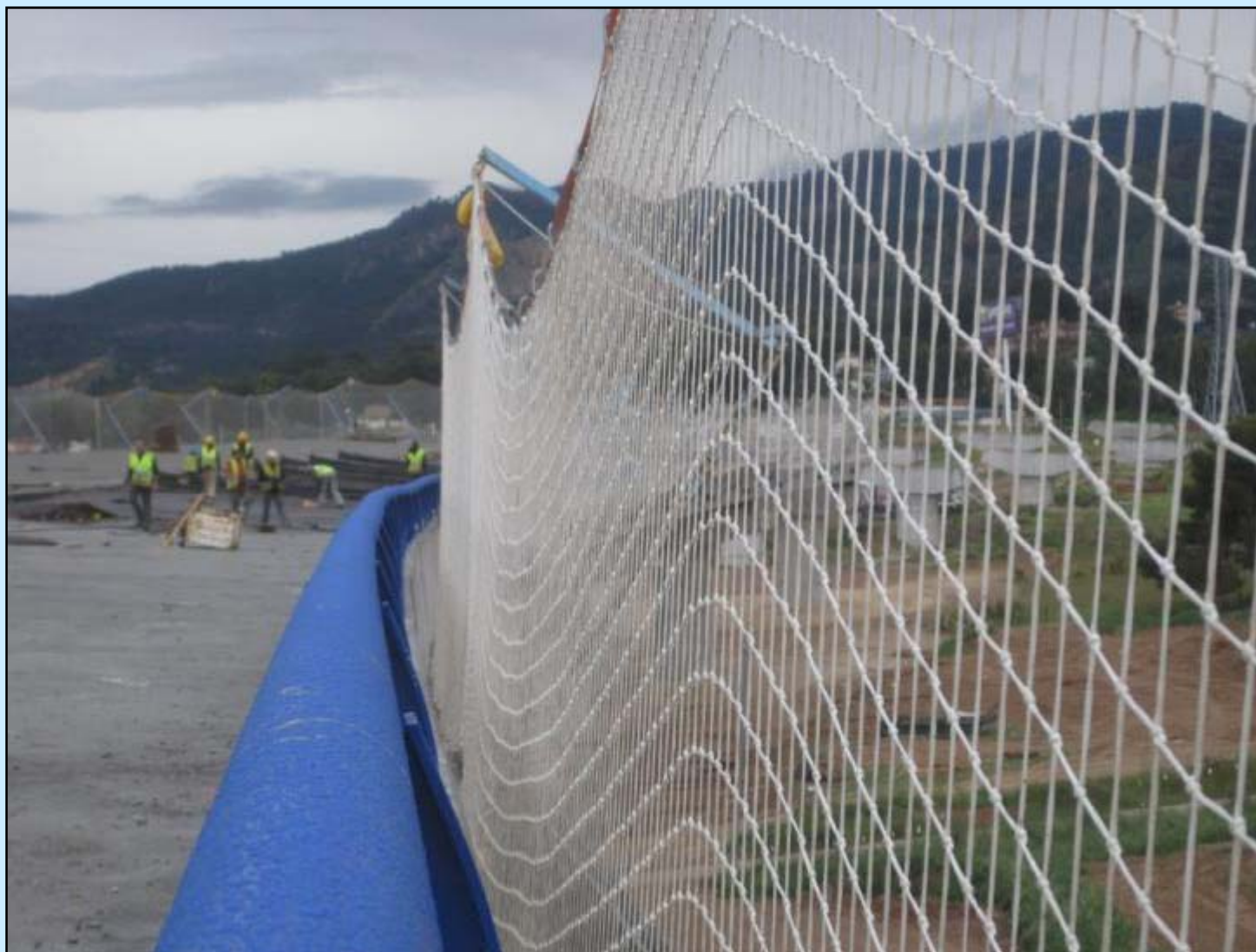
Colocación de impostas
