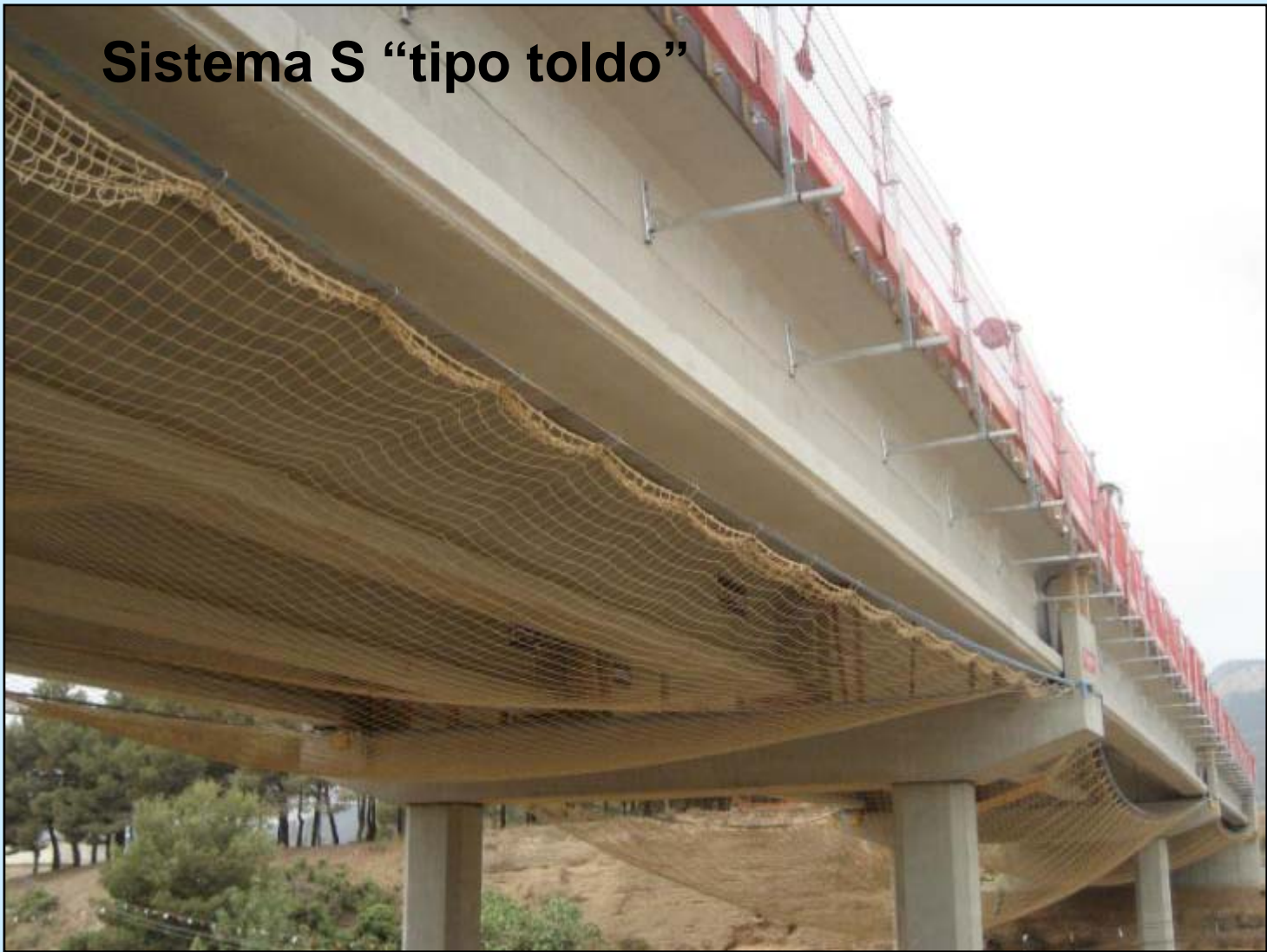
Redes de seguridad Sistema S “tipo toldo” instaladas
