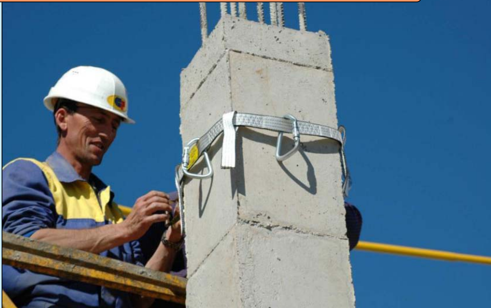
Fijación en cabeza de pilares
