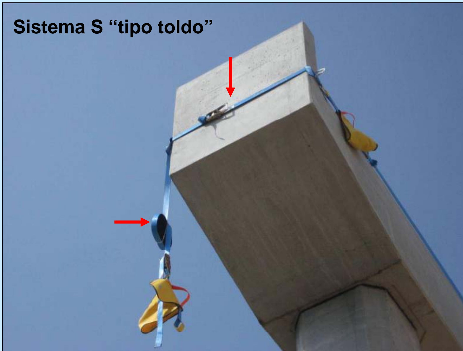
Dintel con dispositivos de anclaje y líneas de sustentación para redes
