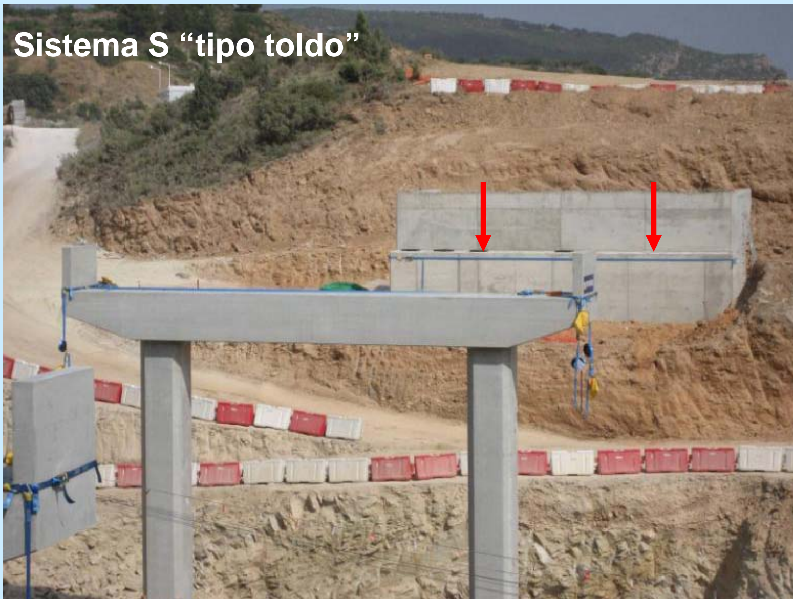
Estribo con líneas de sustentación para redes
