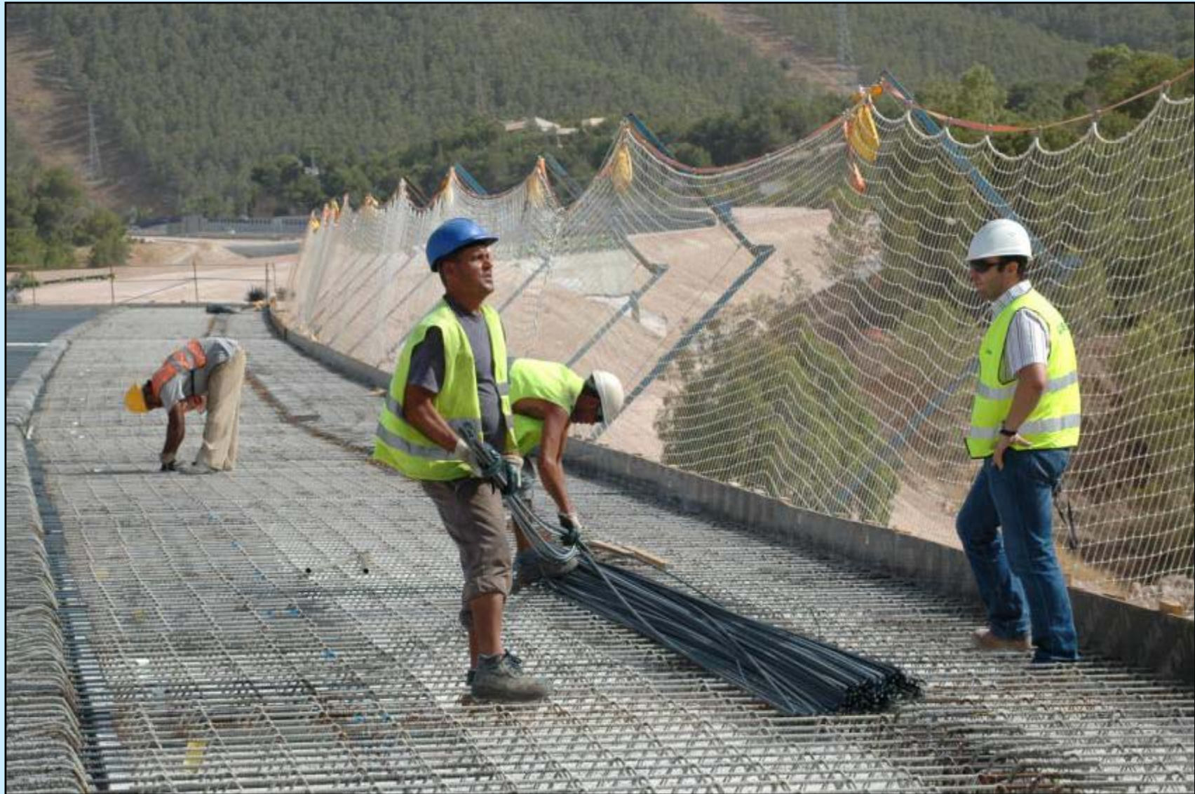
Instalación de ferralla
