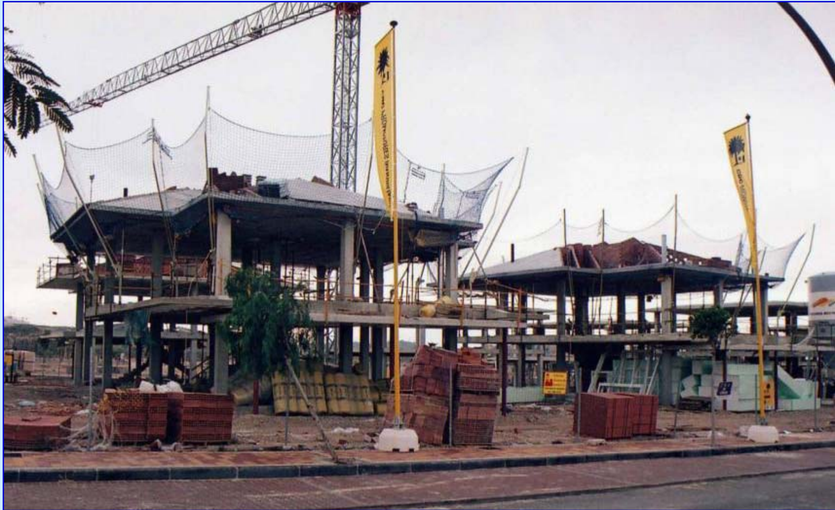
Protección en cubiertas inclinadas / tabique palomero
