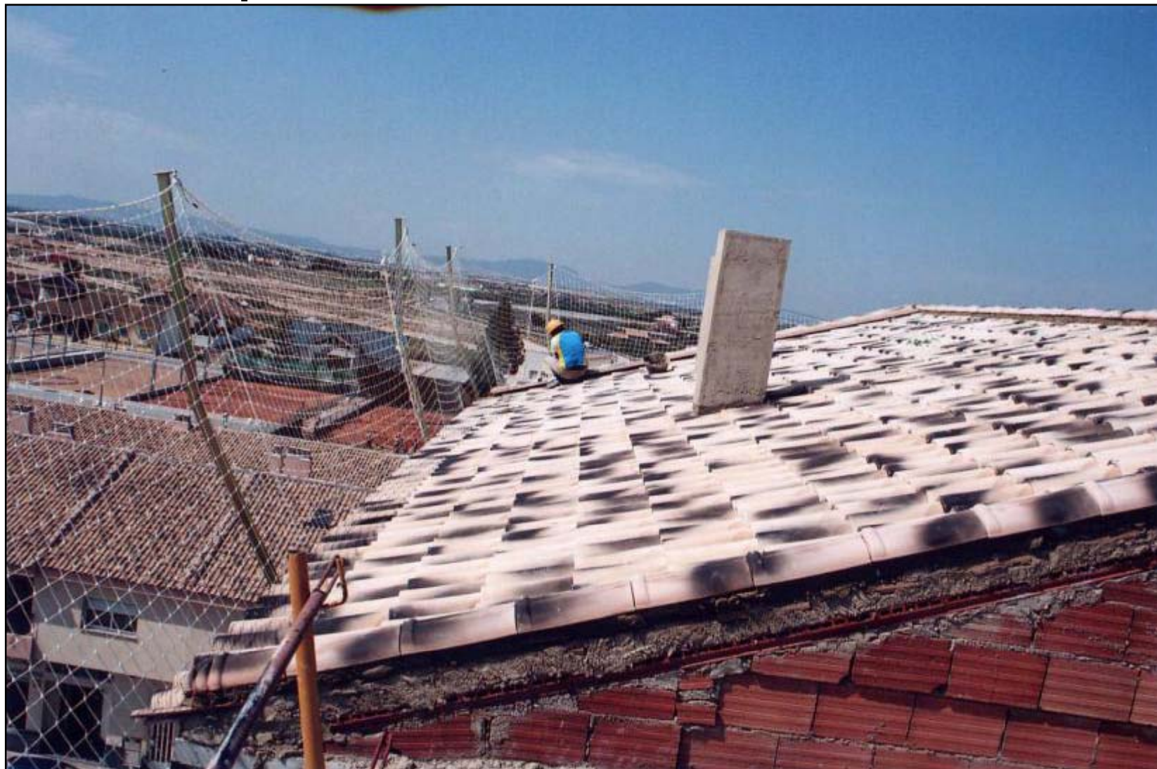
Colocación de teja sin quitar la protección colectiva
