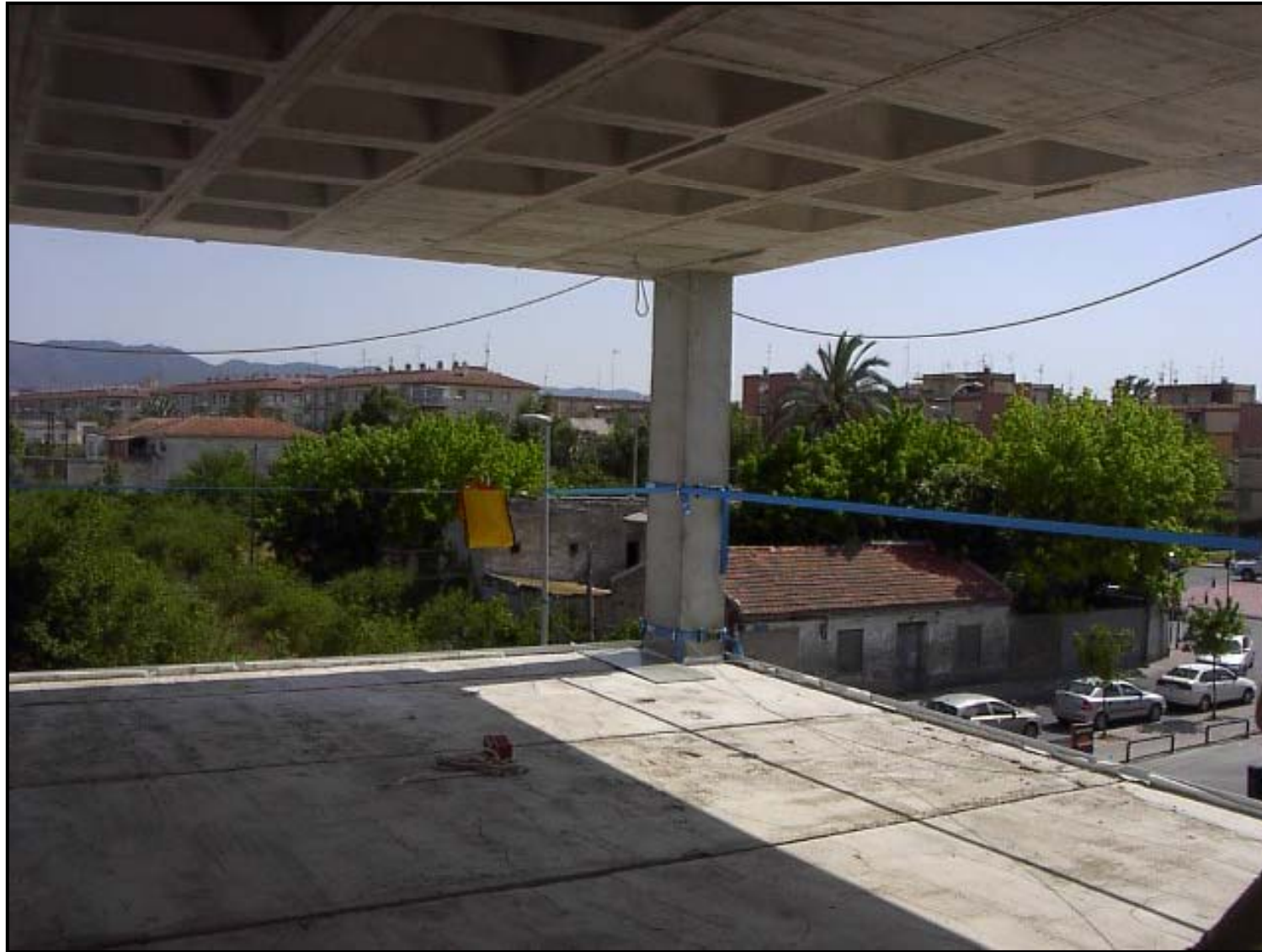
Instalación de soportes y muros cortina
