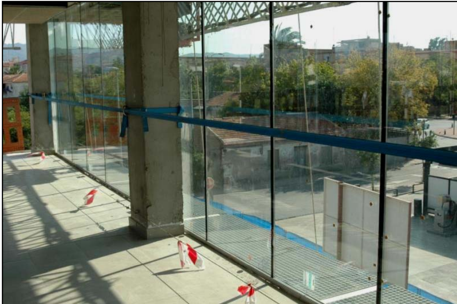
Instalación de muros cortina
