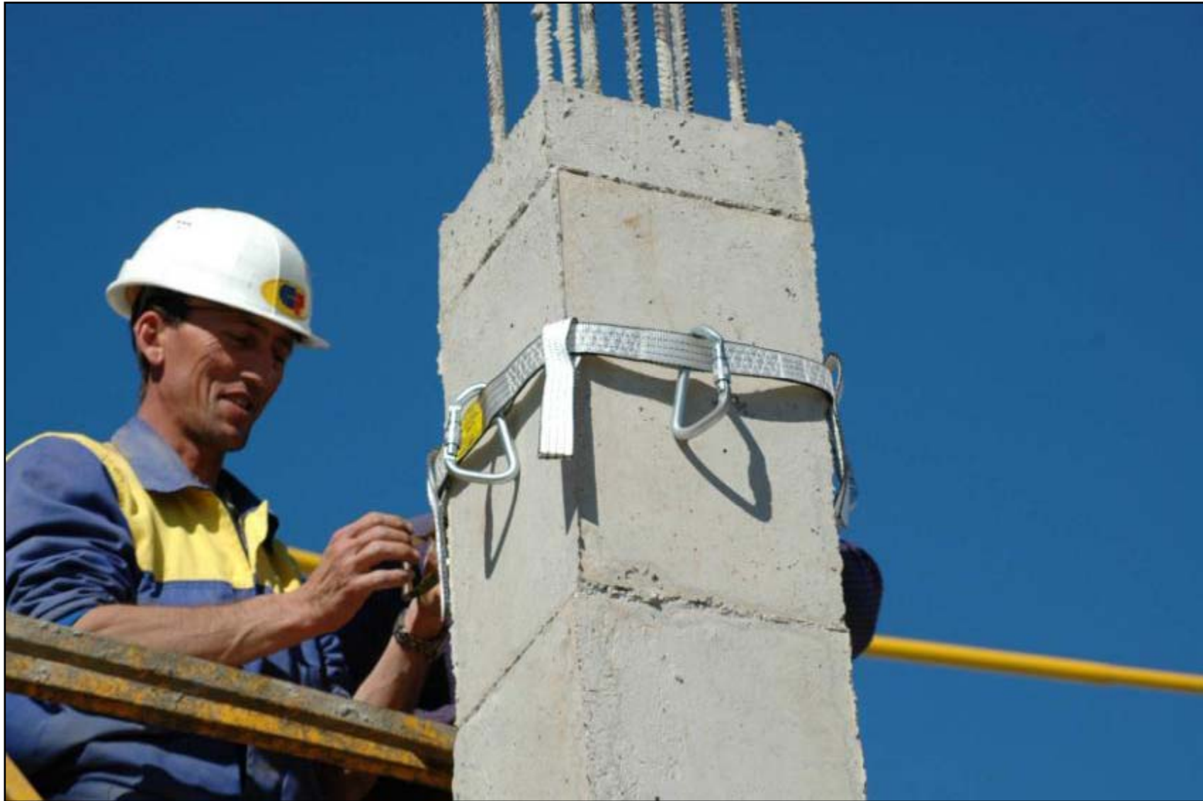
Fijación en cabeza de pilares
