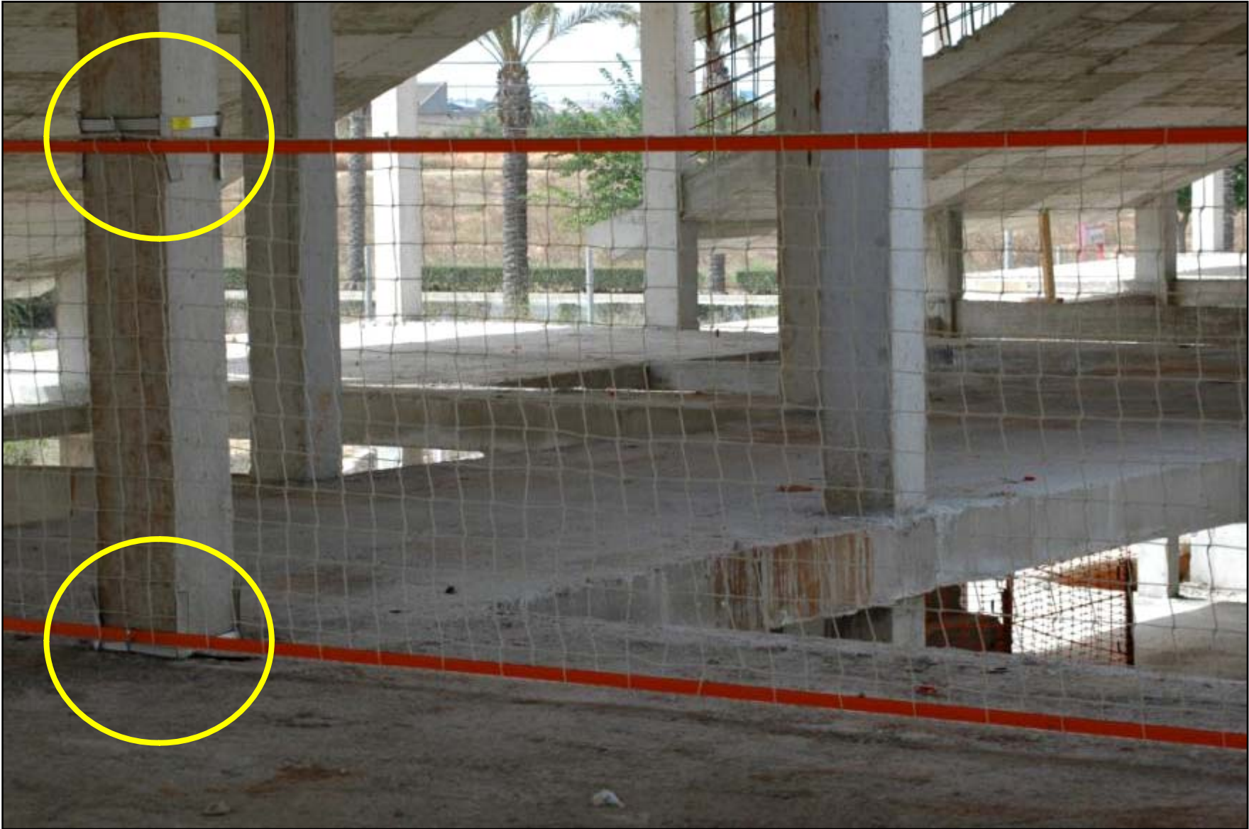
MULTIGARBEN dispositivo de anclaje
