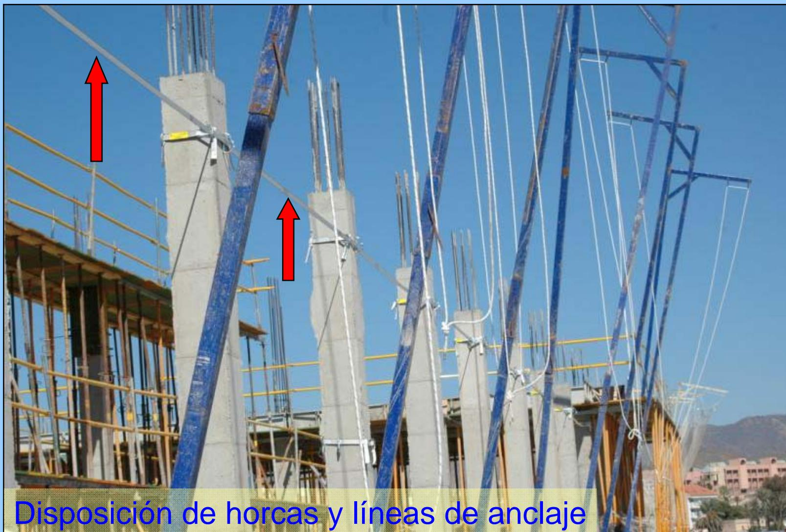
Sistema V con elevación del punto de anclaje – Montaje red.
