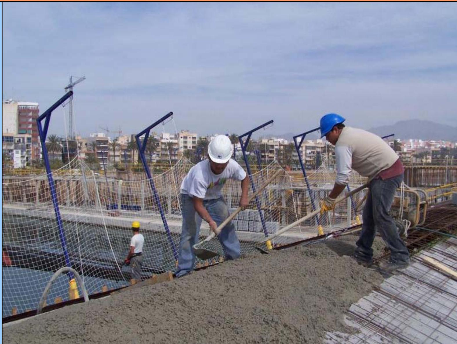
Sistema V con elevación del punto de anclaje – **Perspectiva.**
