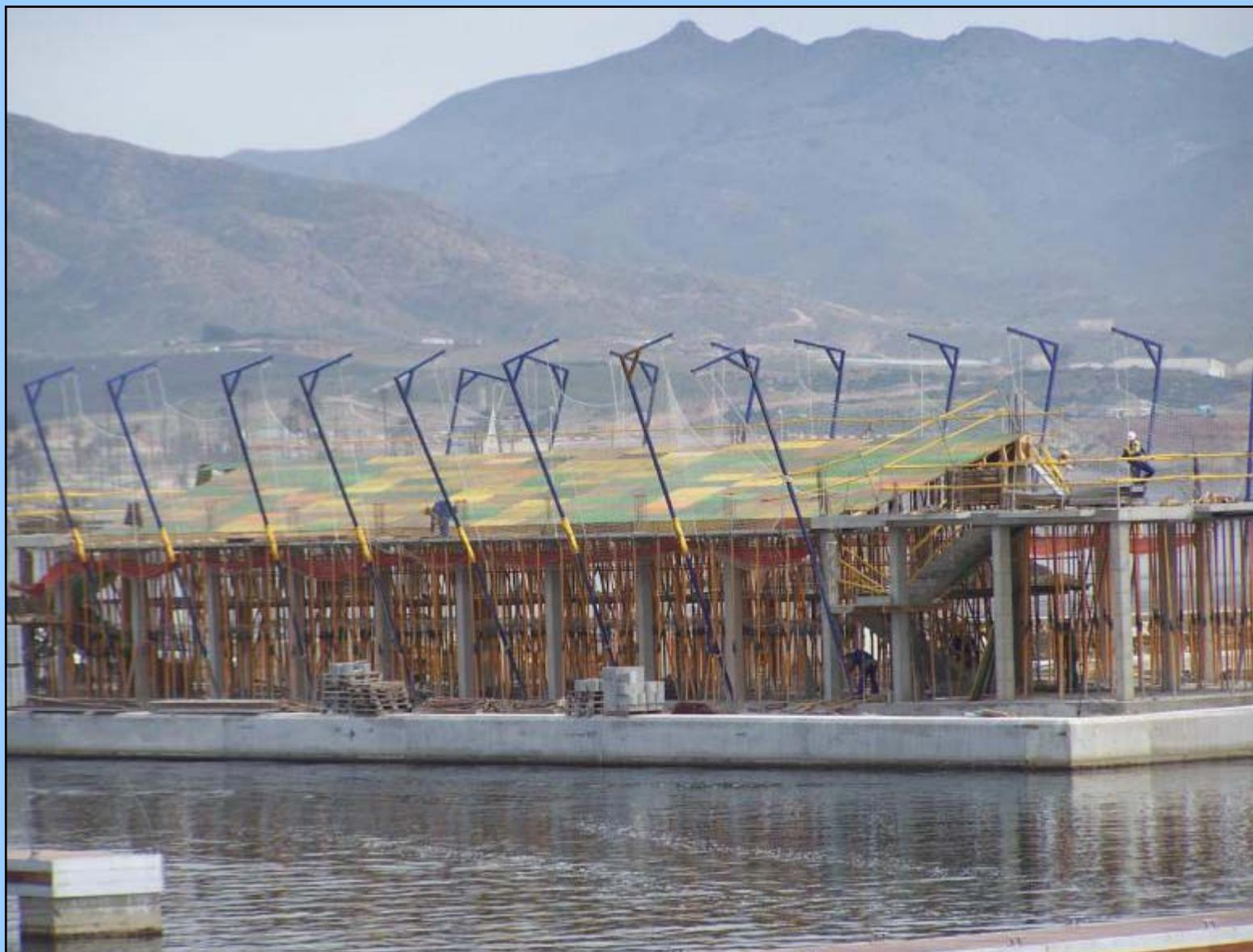
Sistema V con elevación del punto de anclaje – Colocación viguetas
