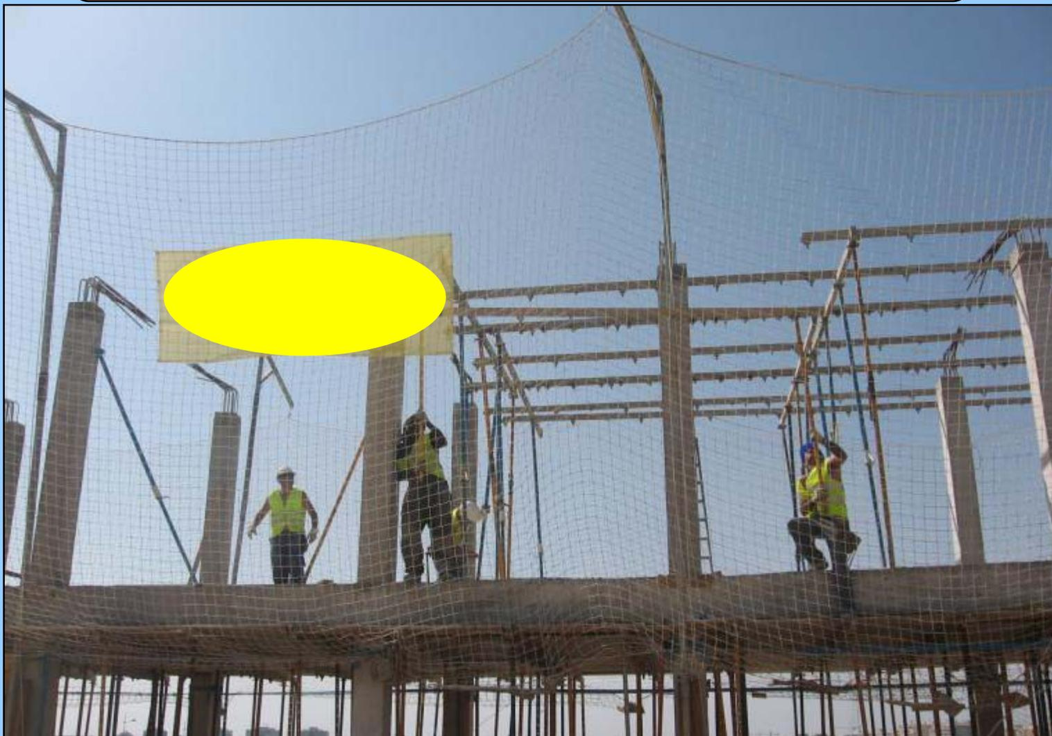
Operarios instalando el mecano de la primera planta
