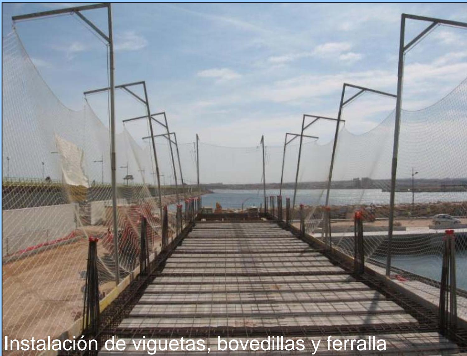
Instalación de viguetas, bovedillas y ferralla
