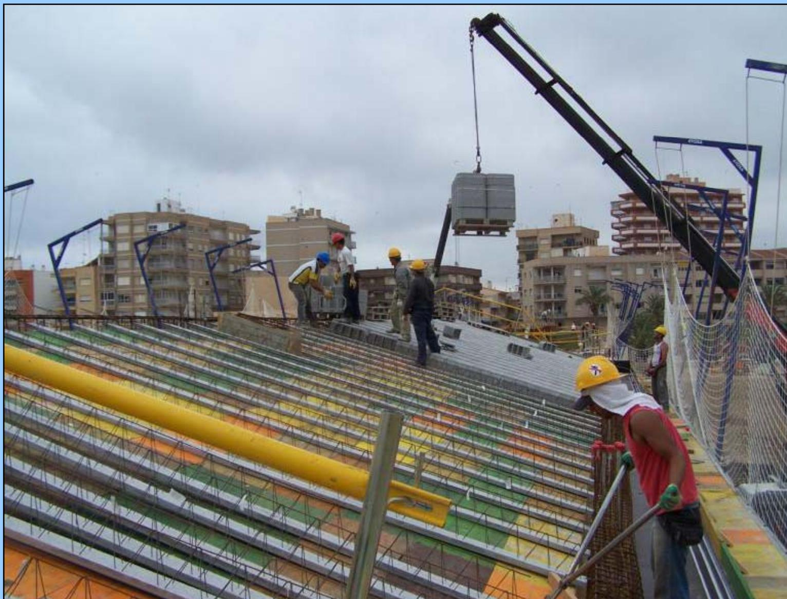
Sistema V con elevación del punto de anclaje – Colocación bovedillas.
