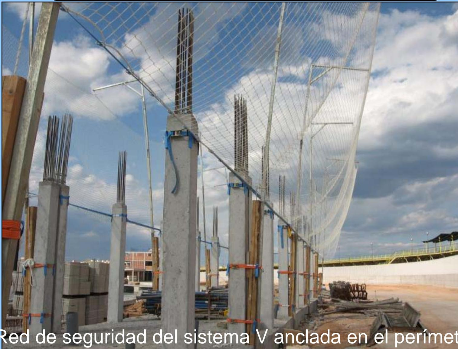
Red de seguridad del sistema V anclada en el perímetro
