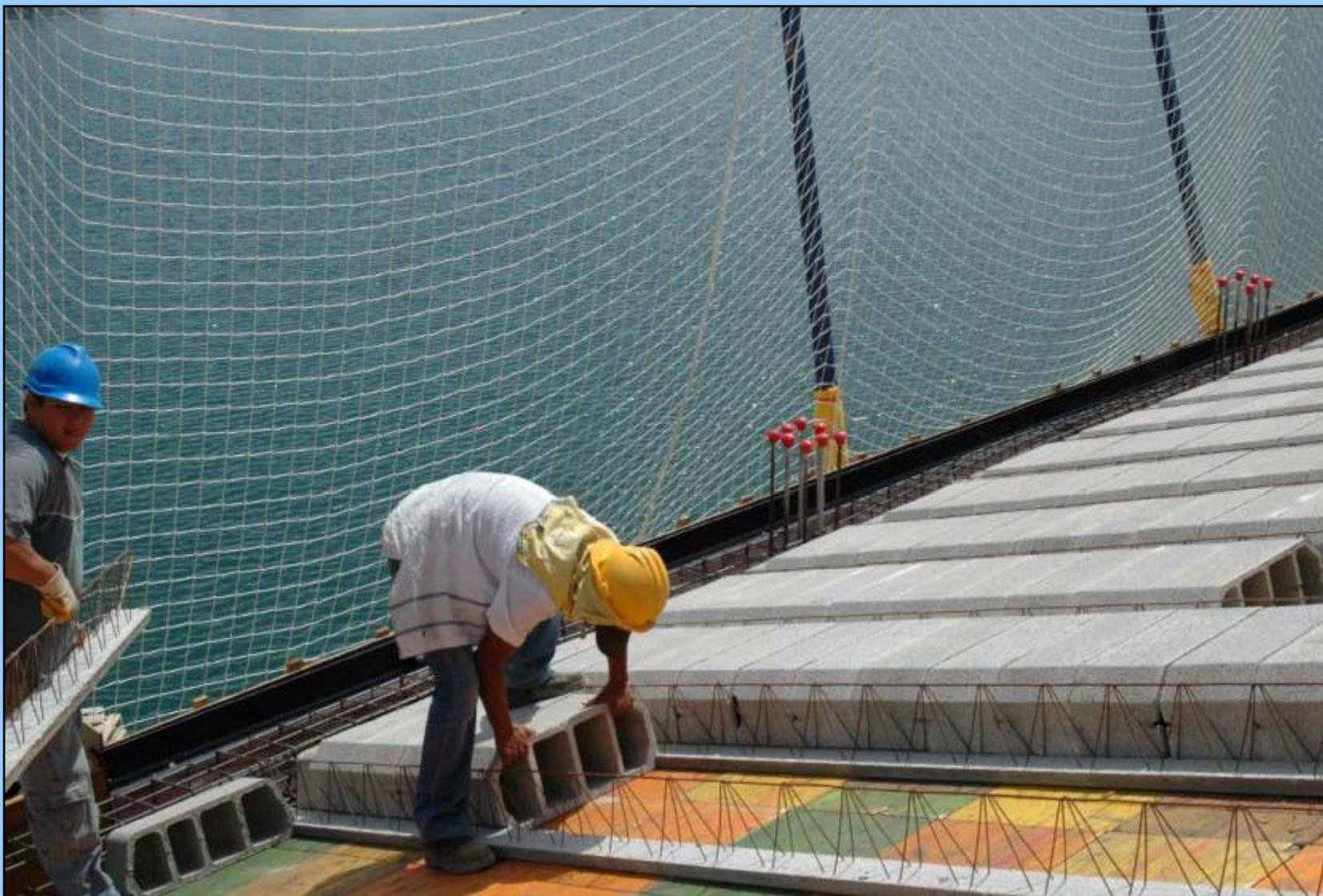
Sistema V con elevación del punto de anclaje – Montaje ferralla
