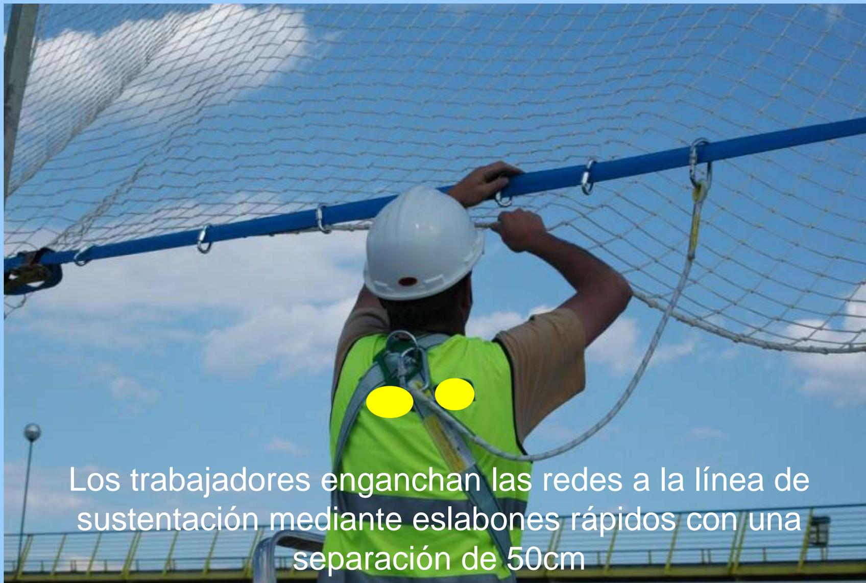
Los trabajadores enganchan las redes a la línea de sustentación mediante eslabones rápidos con una separación de 50cm
