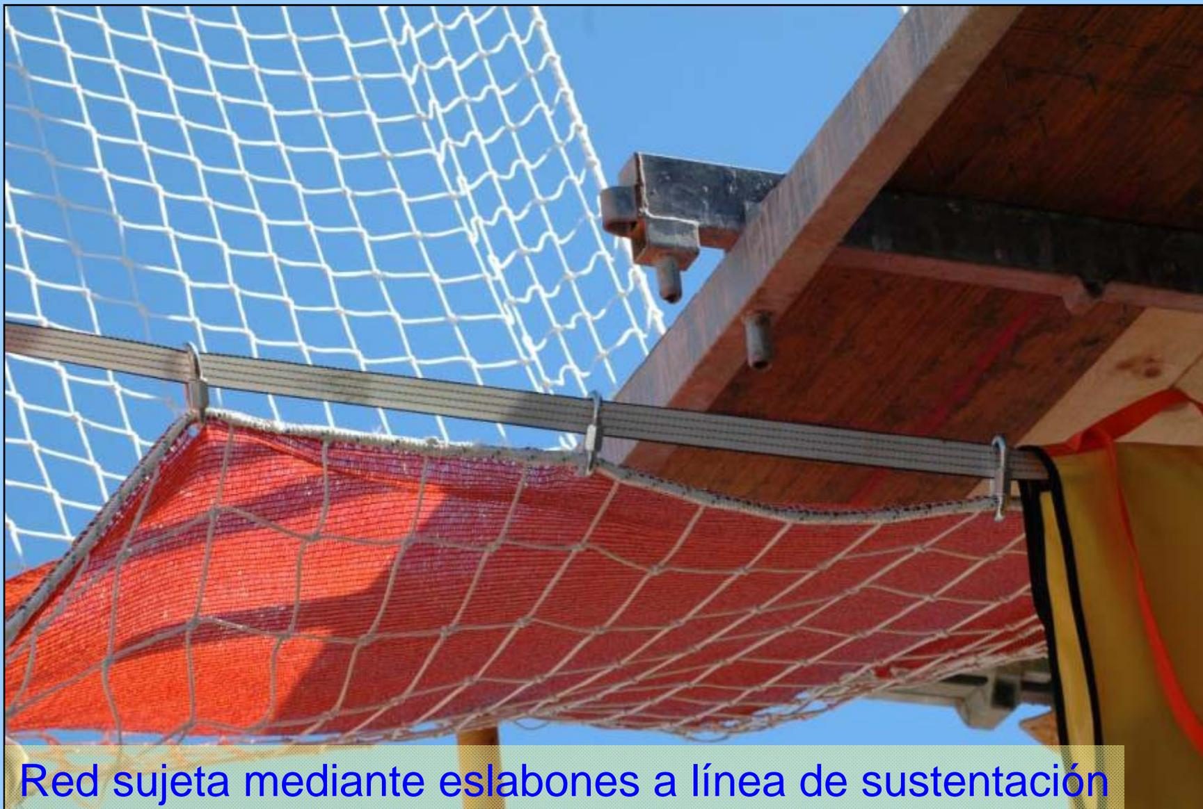
Red sujeta mediante eslabones a línea de sustentación
