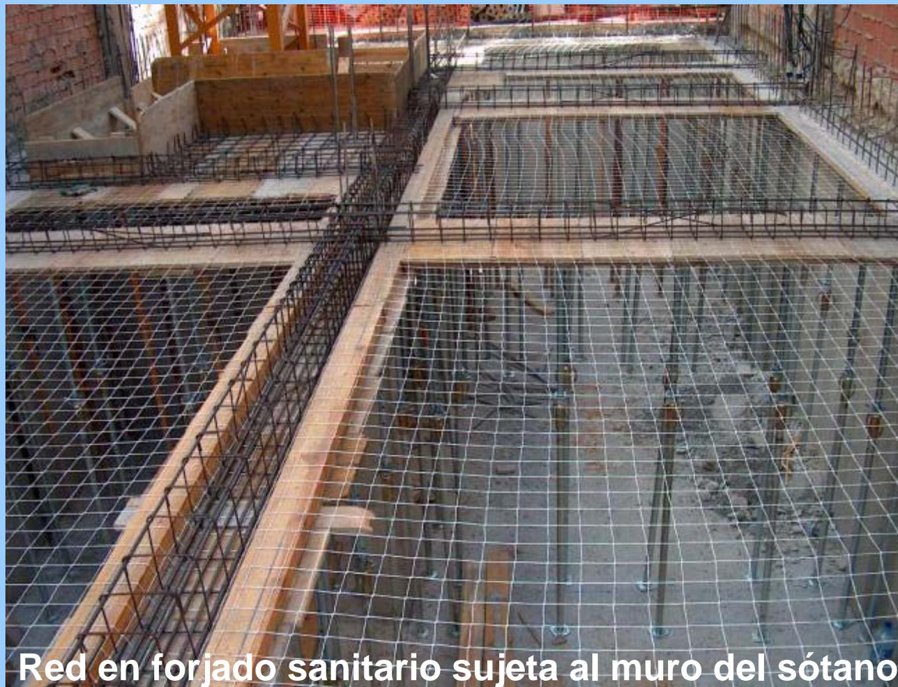
**Red en forjado sanitario sujeta al muro del sótano**
